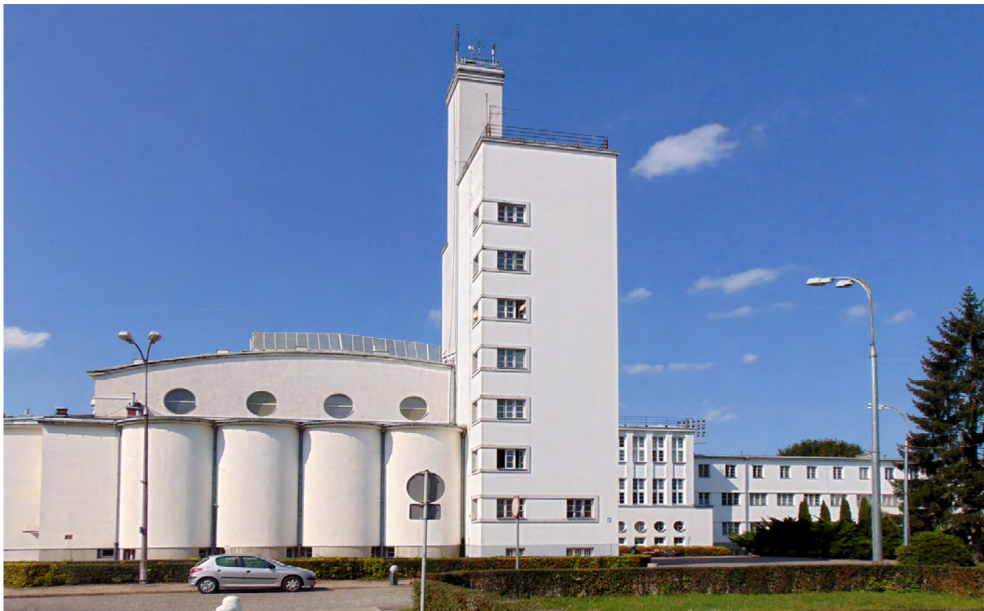
Budynek wieży z blokiem pływalni
