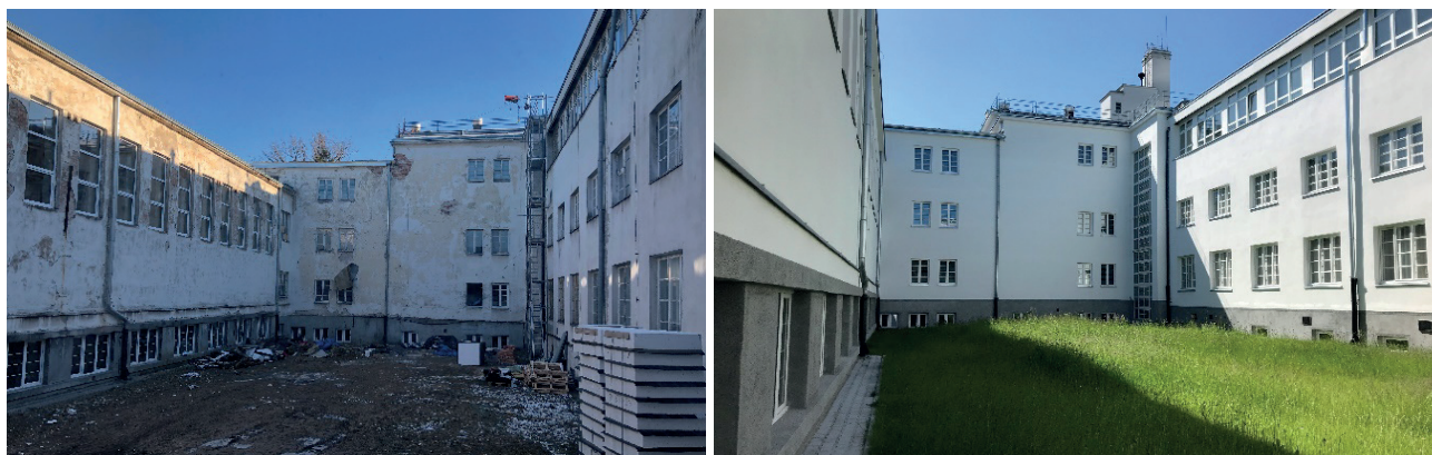
Fot. 9. Patio w budynku głównym (stan w 2019 w trakcie remontu i w 2020 r.; fot. Archiwum AWF Warszawa).
