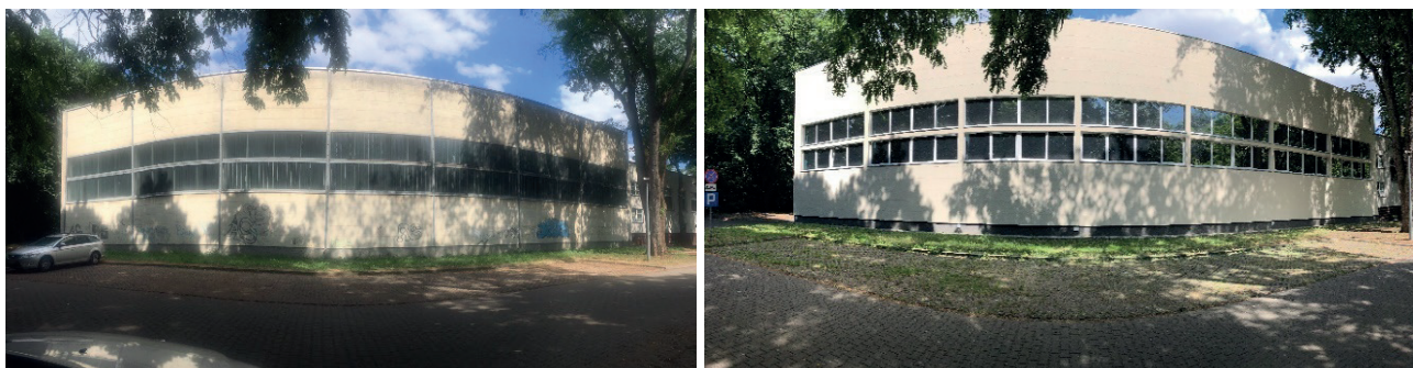
Fot. 10. Sala gimnastyczna – SG5 (stan w 2017 i w 2018 r.; fot. Archiwum AWF Warszawa).
